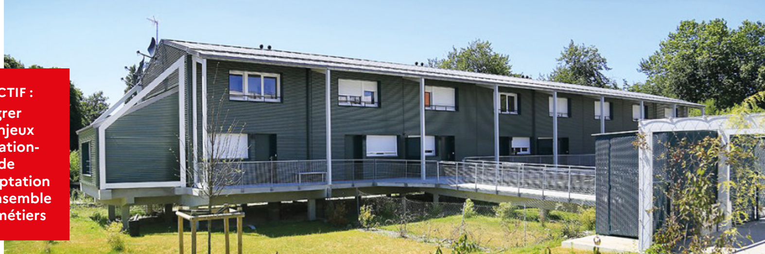
Quartier adapté aux inondations
