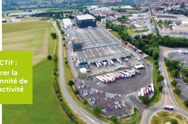
Vue aérienne du site de JFA
