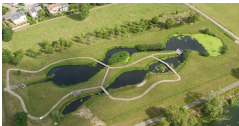
La zone de rejet végétalisée de Thionville. ©Veolia.
