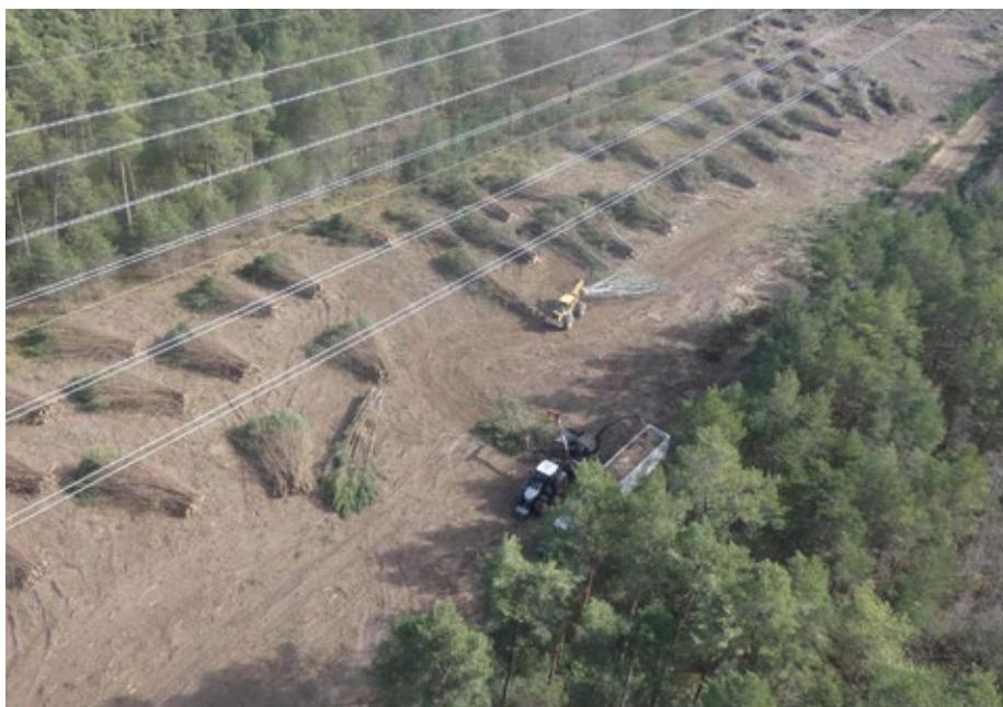
Valorisation de bois coupé sous les câbles RTE sur la commune de Nevoy (45).
