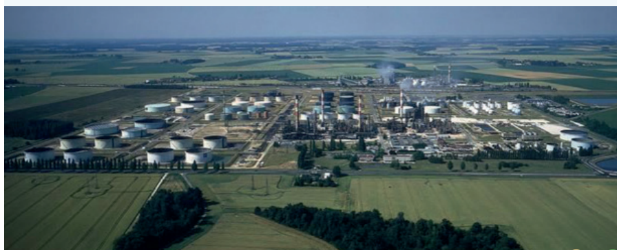
Plateforme de Grandpuits © Total
