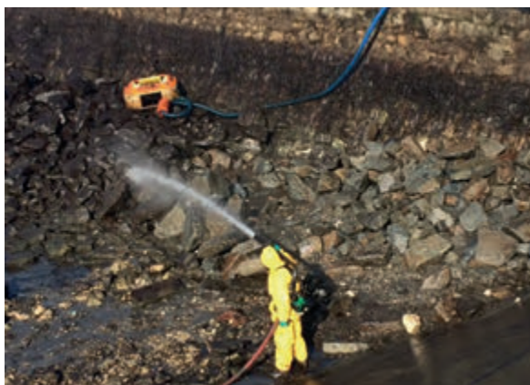
Nettoyage de l'enrochement ©Séché
