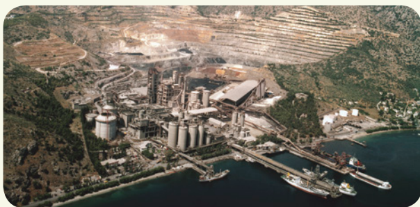
© DR Médiathèque Lafarge Grèce, Volos : 30 000m 3 d'eau sont recyclés tous les ans. La cimenterie de Volos réutilise les eaux usées d'un fabricant de boissons local, réduisant ainsi sa consommation d'eau douce et éliminant les rejets d'eau usées dans la mer.
