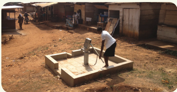
© DR Médiathèque Lafarge Cameroun, Figuil : Lafarge a facilité l'accès à l'eau potable pour 11 villages autour de sa cimenterie de Figuil dans le nord du Pays, en participant à l'installation de 50 puits
