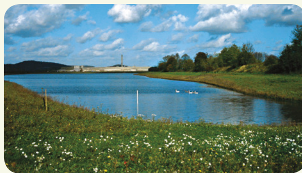
© DR Médiathèque Lafarge France, Longueil Sainte-Marie : Suite à la conversion de la carrière de Longueil, un bassin de contrôle des crues de 600 000 m 3 a été construit en partenariat avec les pouvoirs publics locaux, afin de réduire le risque d'inondation en Picardie.
