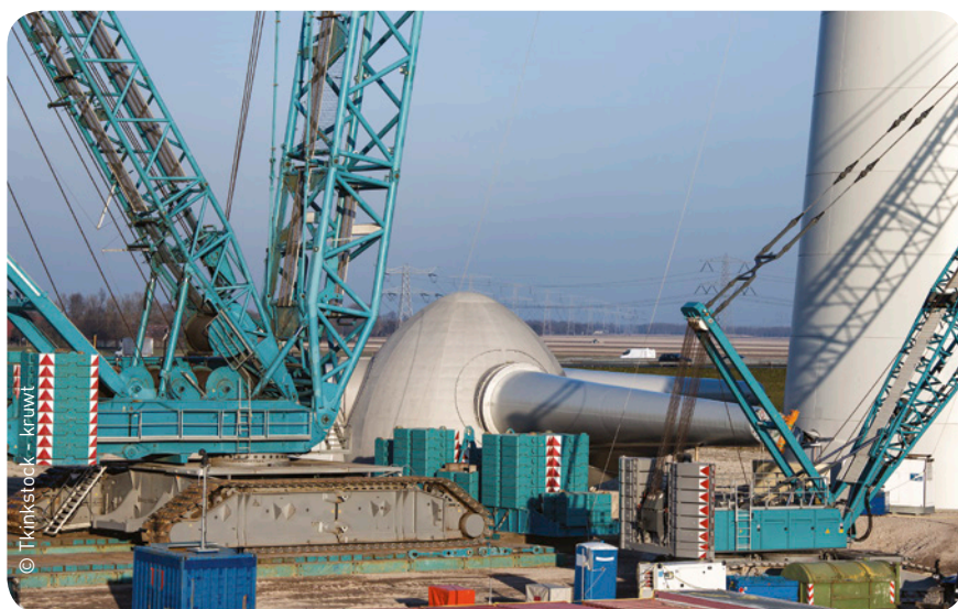
Chantier d'une éolienne terrestre
