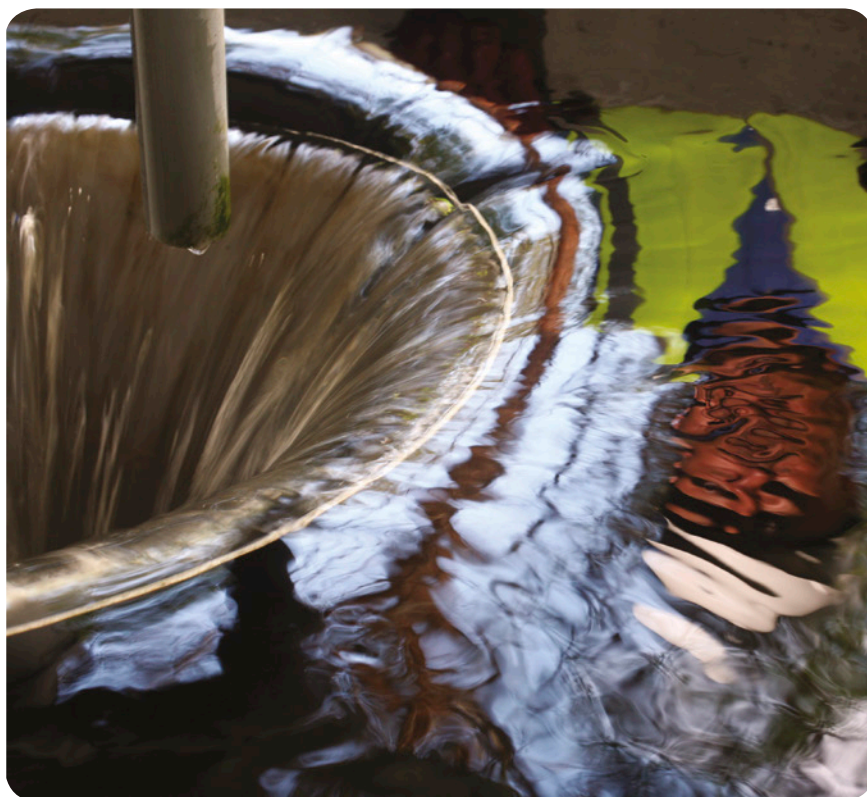
Usine de dessalement d'eau de mer de Melbourne, Suez Environnement
