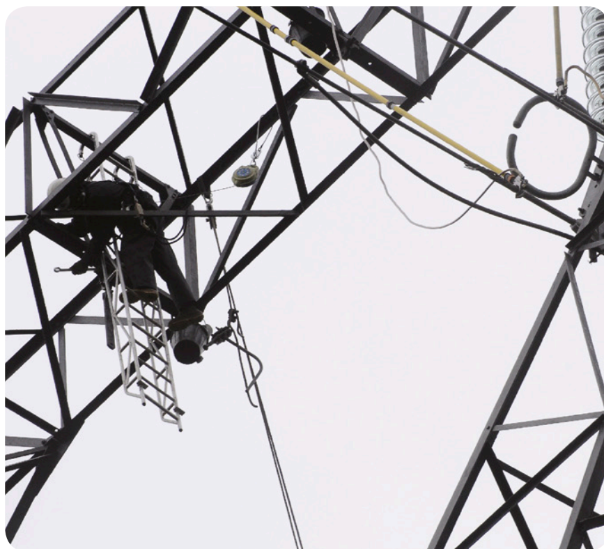
Intervention d'une équipe ligne de RTE après la tempête Klaus du 24 janvier 2009
