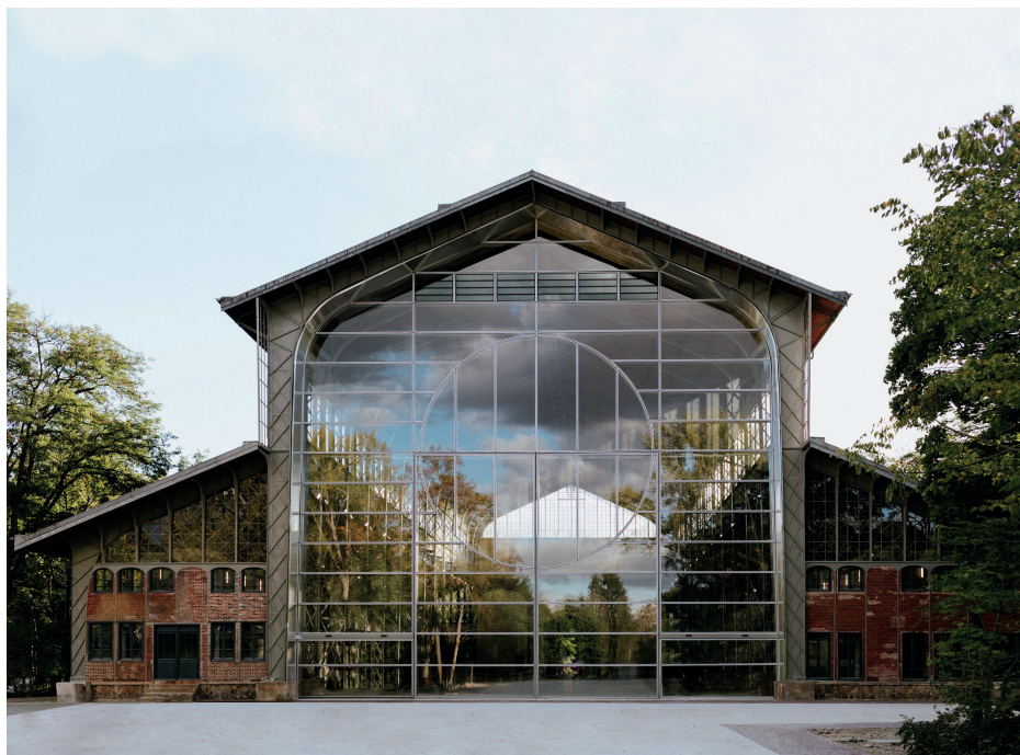
VINCI continue de transformer ses modèles opérationnels pour protéger les sols et mettre en œuvre la sobriété foncière.
