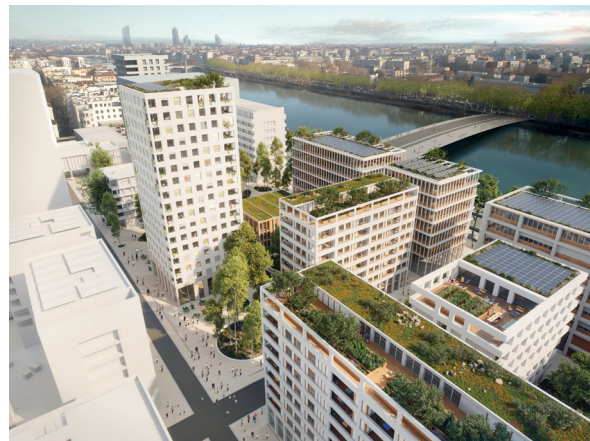
Bâtiment Essentiel project, Lyon Confluence © Baumschlager Eberle
